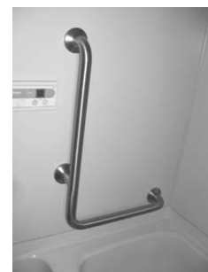
「浴室」の手すり設置例
