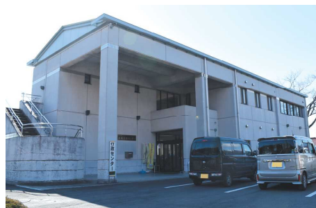
組織体制の見直しを行い行政センターの機能強化を図ります(写真は赤城行政センター)
