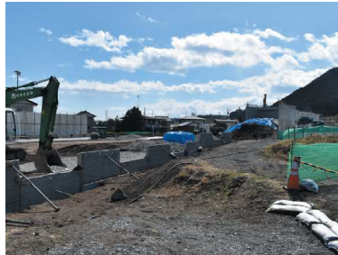
整備が進む上信自動車道
