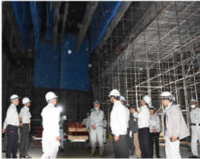
工事中の外観(上段)と大ホール(下段)
