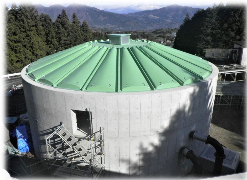
改築工事を実施中の物聞沢水質管理センター
