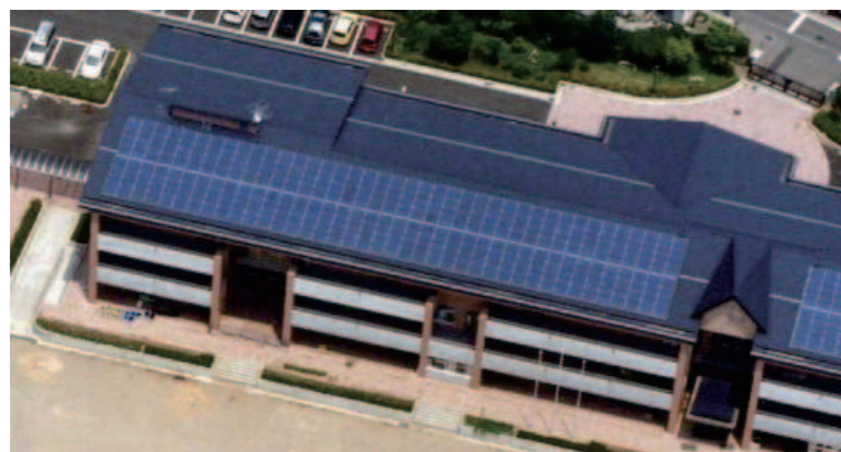
渋川南小学校屋根への設置状況
