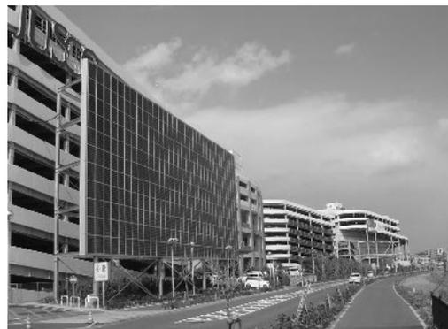
ショッピングセンターの壁面に設置した太陽光発電システム
