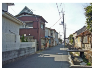
②狭い道路に面する住宅
