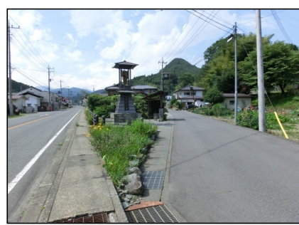
②現況写真
