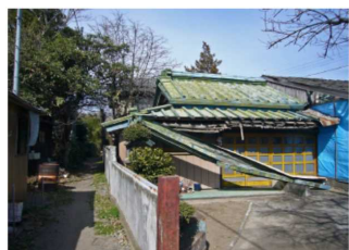
①老朽化した空き家
