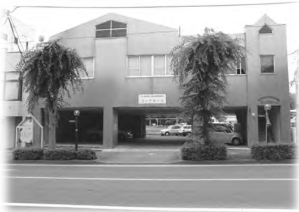
渋川駅前通り商店街における活性化の拠点「エッグホール」
