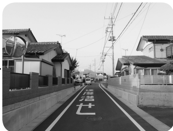
市道吹屋原浅田線〈道路改良後〉
