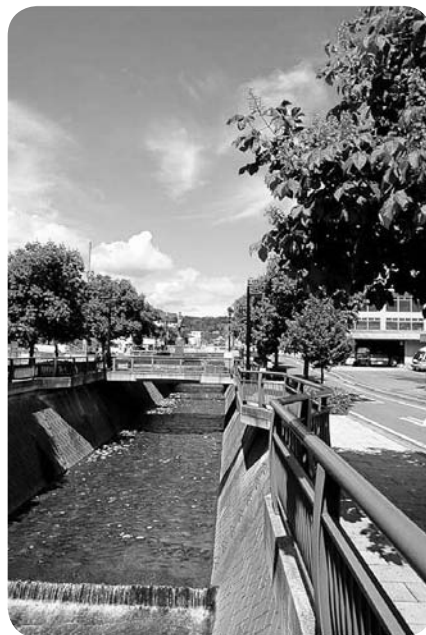
護岸整備された平沢川
