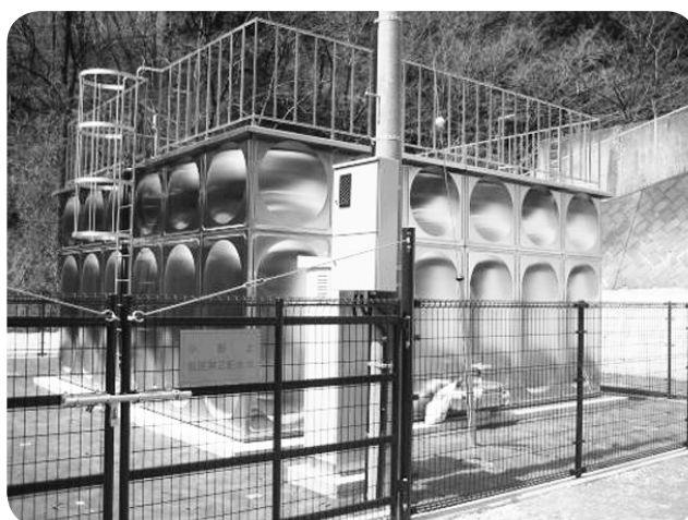
小野上地区低区第2配水池
