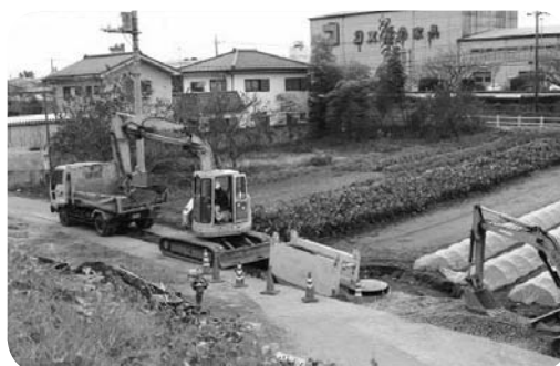
公共下水道の整備
