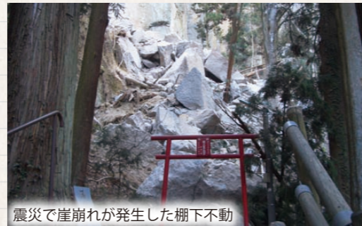
震災で崖崩れが発生した棚下不動
