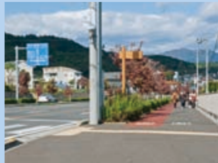
歩道の段差解消
