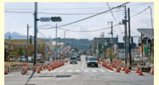
区画整理工事中の四ツ角
