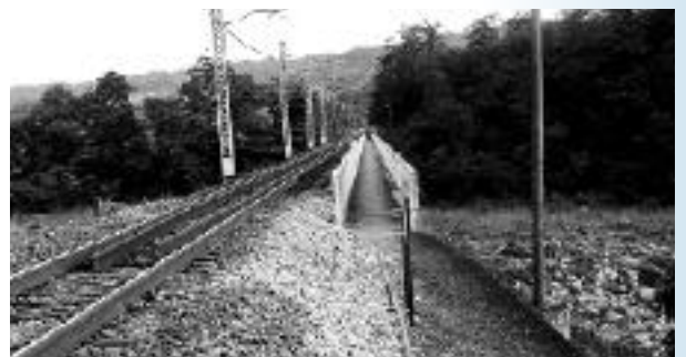
橋りょう整備が期待される歩道橋
