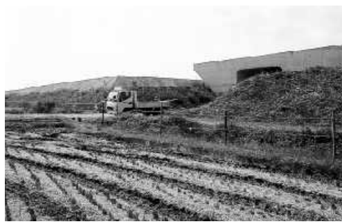
半田地内で建設中の前渋バイパス
