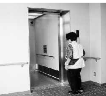
条例違反が指摘されたエレベーター
