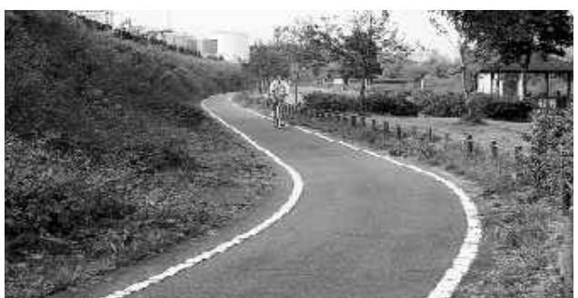
利根川サイクリングロード(大崎地内)
