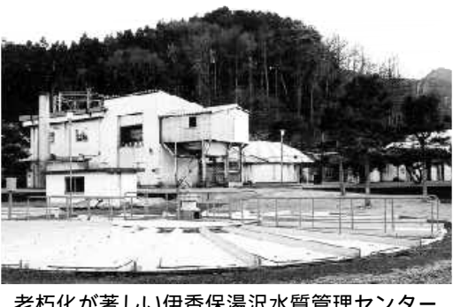
老朽化が著しい伊香保湯水質管理センター
