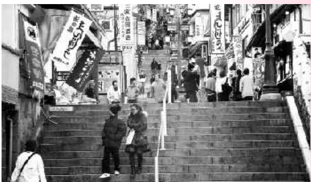
石段街に設置されている手すり
