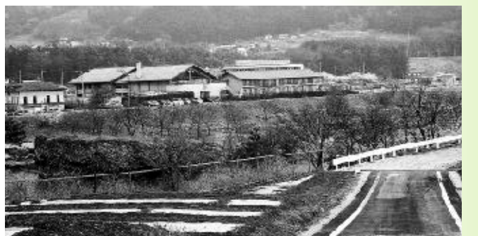
要望のある利根川架橋
