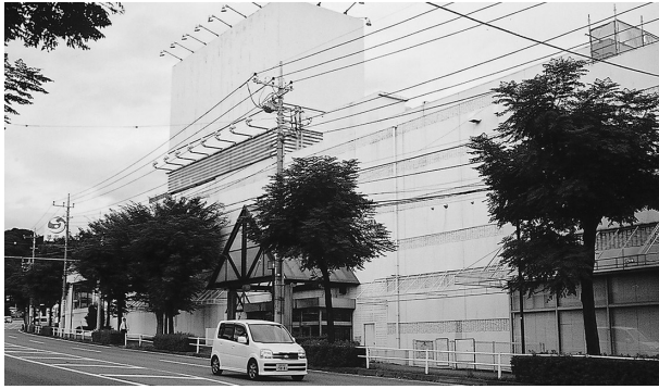
1階部分が改修される第二庁舎
