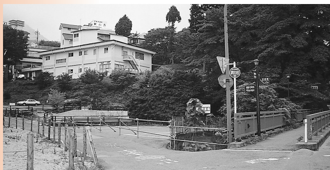
期待される関屋橋広場の整備
