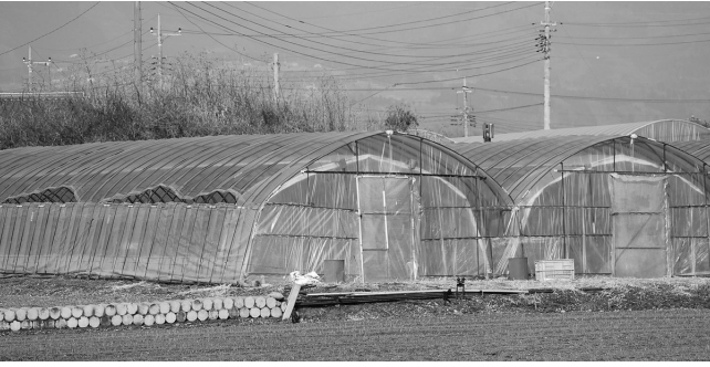
農業用のパイプハウス
