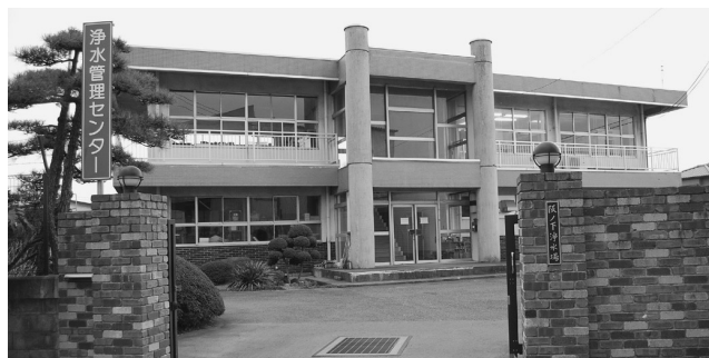
阪ノ下浄水場
