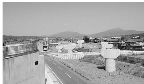
工事が進む前橋渋川バイパス
