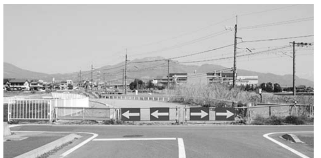
平成22年完成予定の(仮称)辰巳町有馬線
