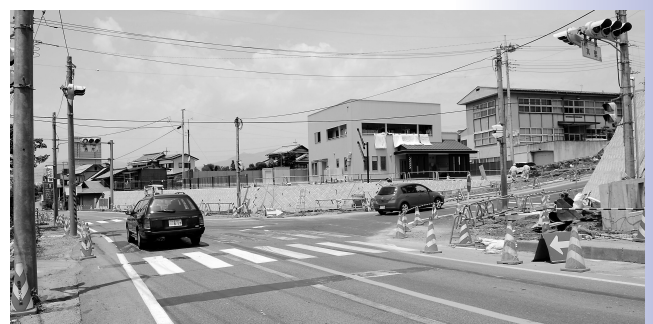
整備中の真壁交差点
