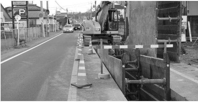
川島地区の下水道工事
