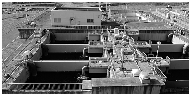
県央第二水道浄水場
