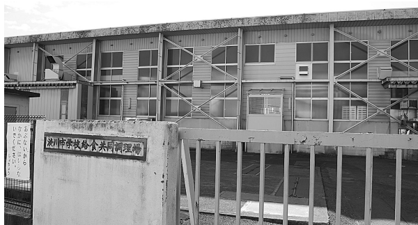
老朽化した渋川学校給食共同調理場
