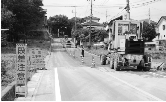
緊急経済対策による舗装工事（市道三国線）
