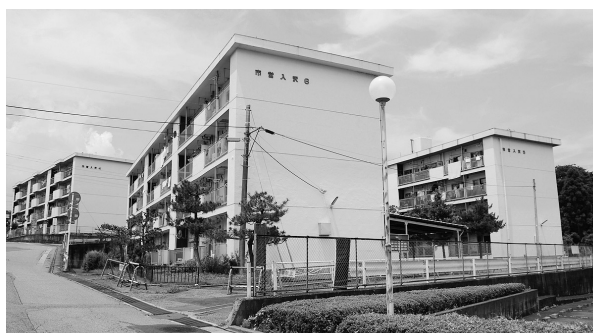
整備の進む公共下水道（入沢団地）
