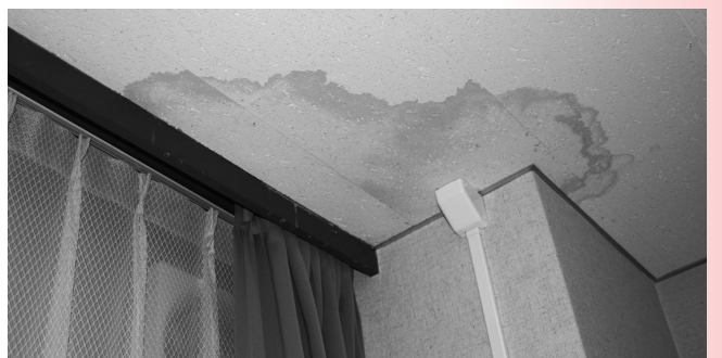
後年度負担となる公共施設老朽化（市役所本庁舎）
