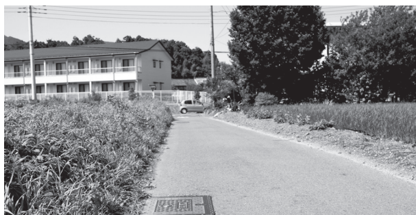
水道管更新済み箇所
