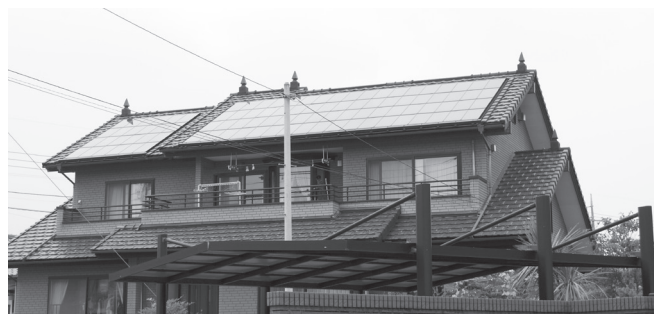
太陽光パネル
