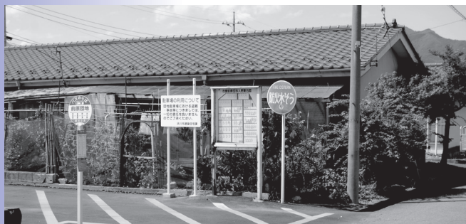
改修が待たれる前原団地
