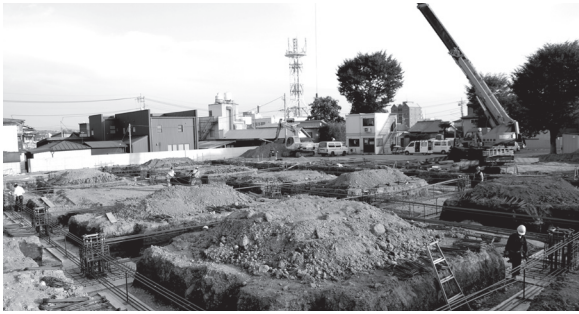
進む渋川幼稚園建設工事
