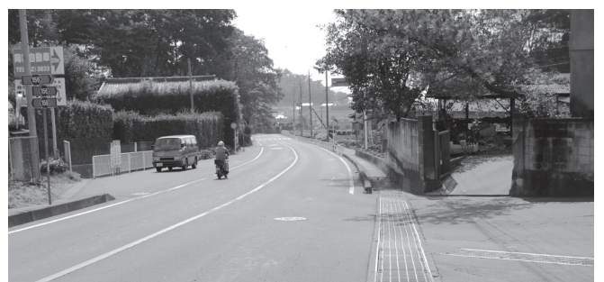
冠水対策が急がれる県道
