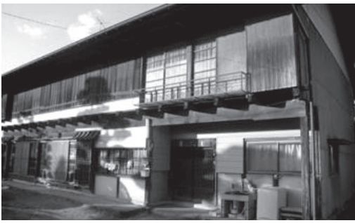
まちなかの空き家
