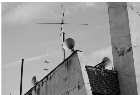
本庁舎屋上の防災行政無線
