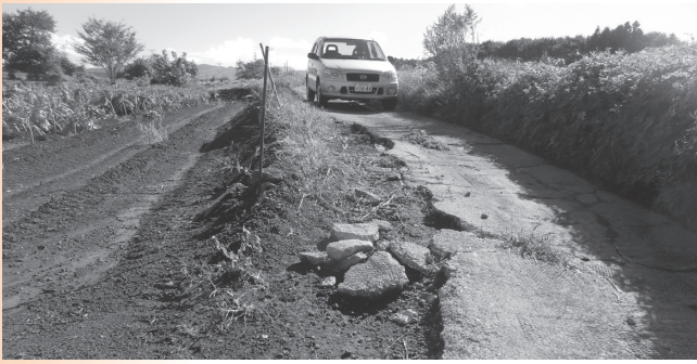
土地改良予定地（上狩野地区）
