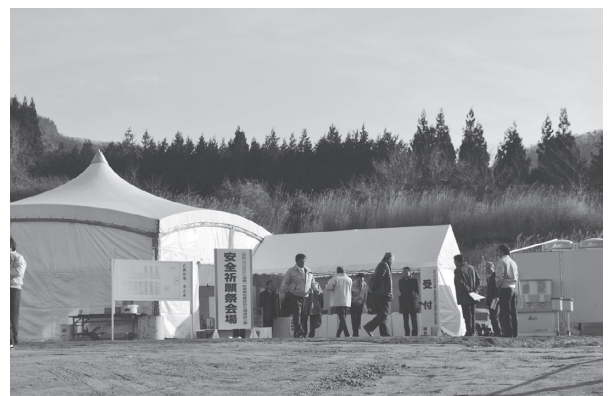
小野上処分場の安全祈願祭
