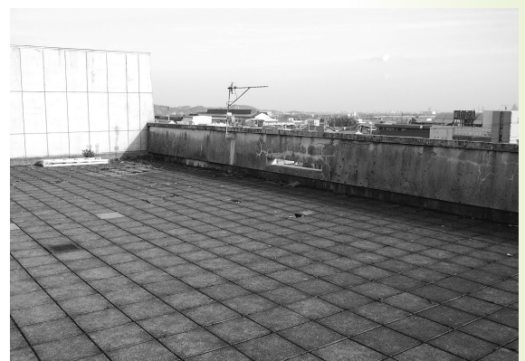
老朽化した本庁の屋上
