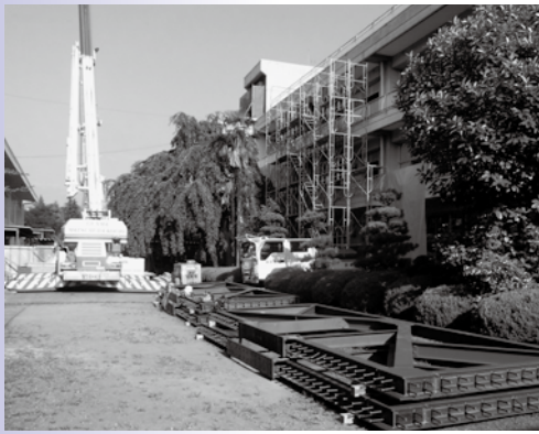
耐震工事中の渋川北小
