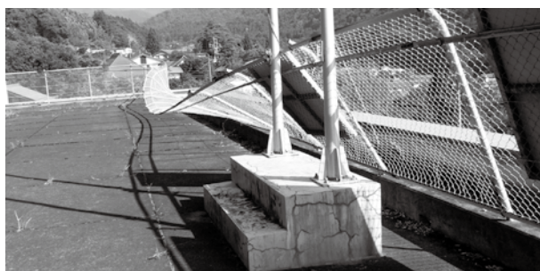
台風で破損した屋上フェンス
