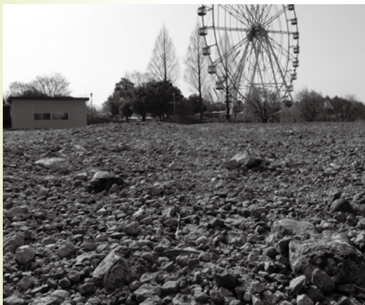
スラグ碎石が露出している スカイランドパーク駐車場
