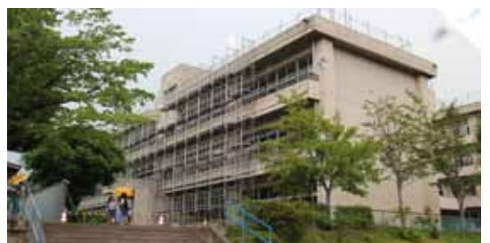
耐震補強始まる 豊秋小学校
