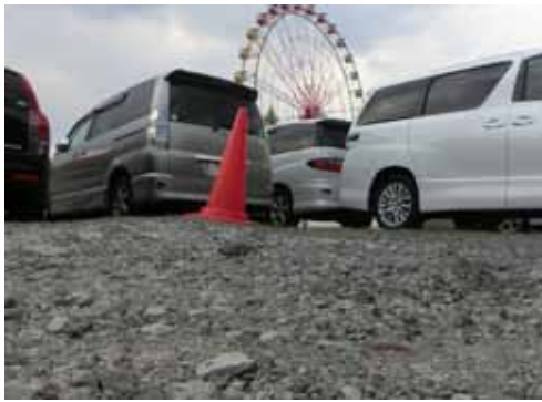
スラグむき出しの スカイランドパーク駐車場
