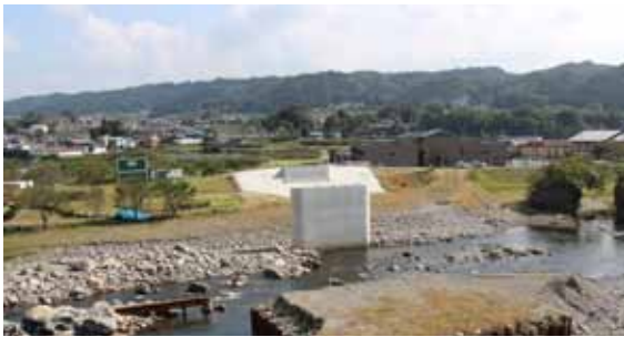
建設中の（仮称）中郷敷島橋
