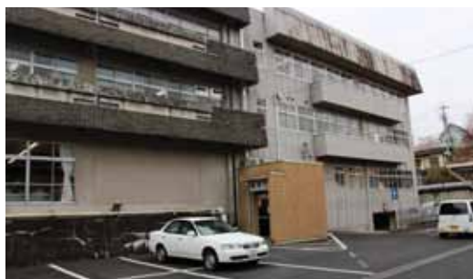
老朽化が進む本庁舎
